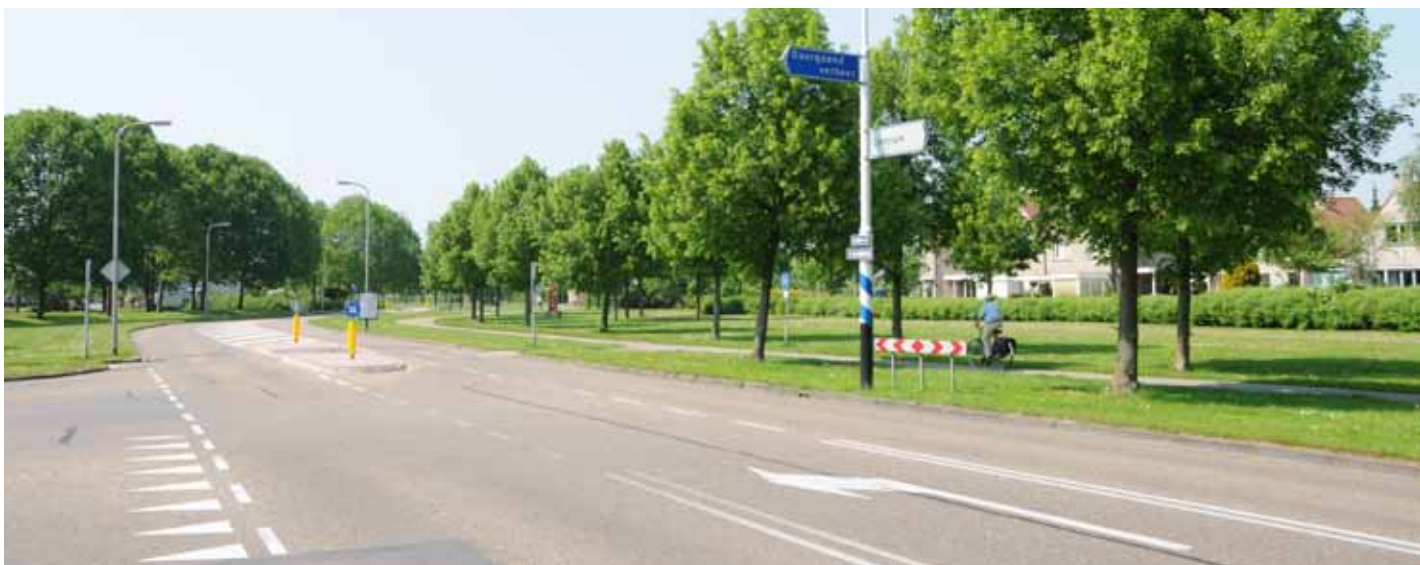
De Zuid is momenteel geen doorlopende route. Komend vanuit het centrum moet het doorgaand verkeer ter hoogte van De Landmaten linksaf slaan om op de Dronterweg uit te komen (foto: Google Street View).
